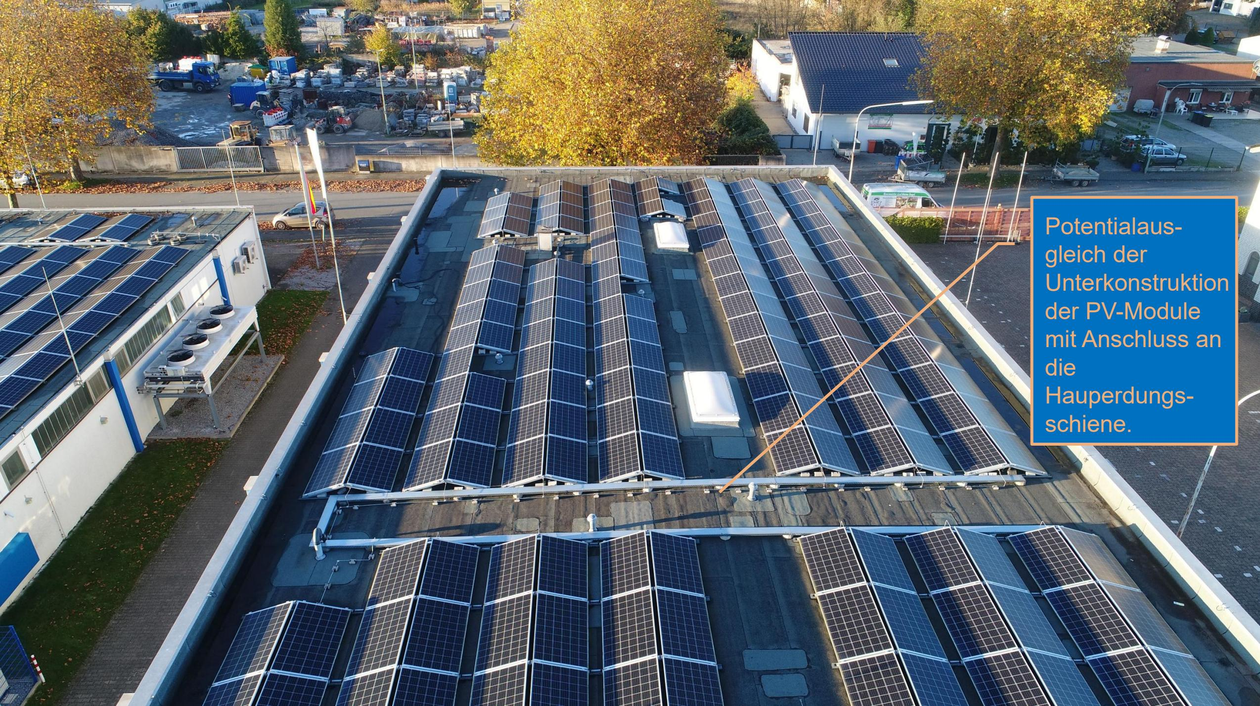
Potentialausgleich der Unterkonstruktion der PV-Module mit Anschluss an die Hauperdungschiene.
